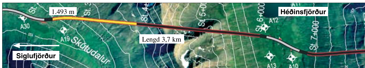
Staða framkvæmda við Héðinsfjarðargöng 30. apríl 2007. Búið er að sprengja 1.493 m í Siglufirði og 1.160 m í Ólafsfirði.
