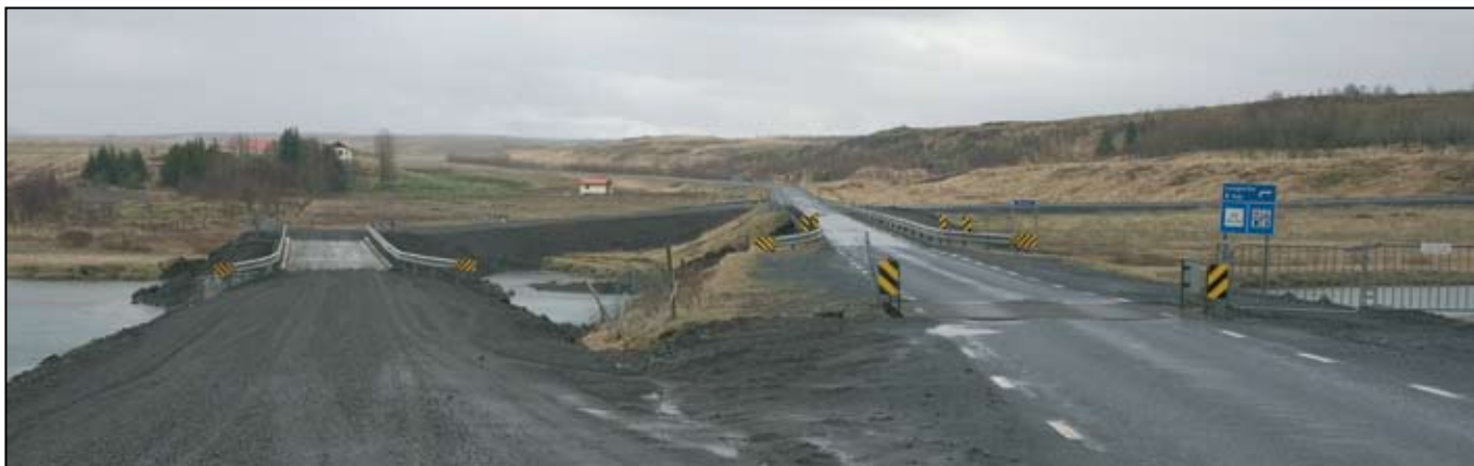
Biskupstungnabraut (35). Nú er lokið við að gera bráðabirgðarbrú á Brúará. Þá verður fljótlega farið í að rífa núverandi brú og byggja nýja tvíbreiða brú á sama stað.
